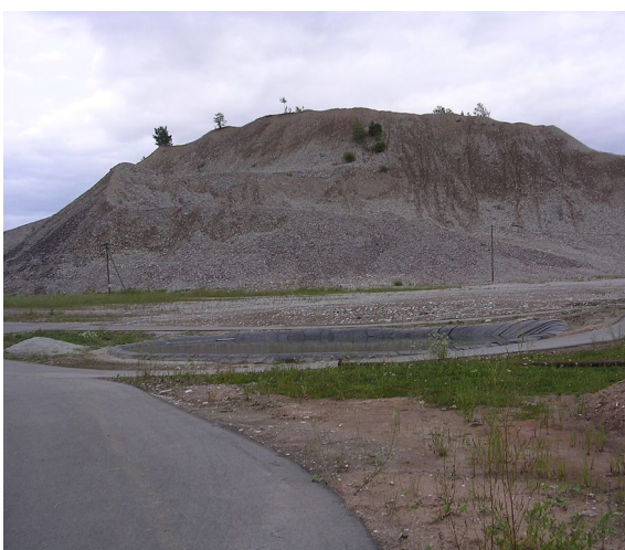
• Põlevkivitööstuse aherainemägi | foto Aulo Aasma
